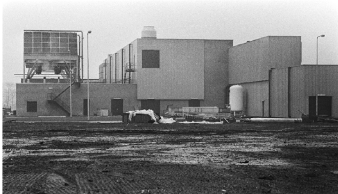
UCN Almelo in aanbouw, 1976
